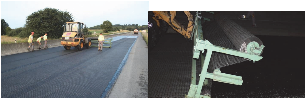
Figure 5. Mise en œuvre de la grille polyester au moyen d'un dérouleur spécial
