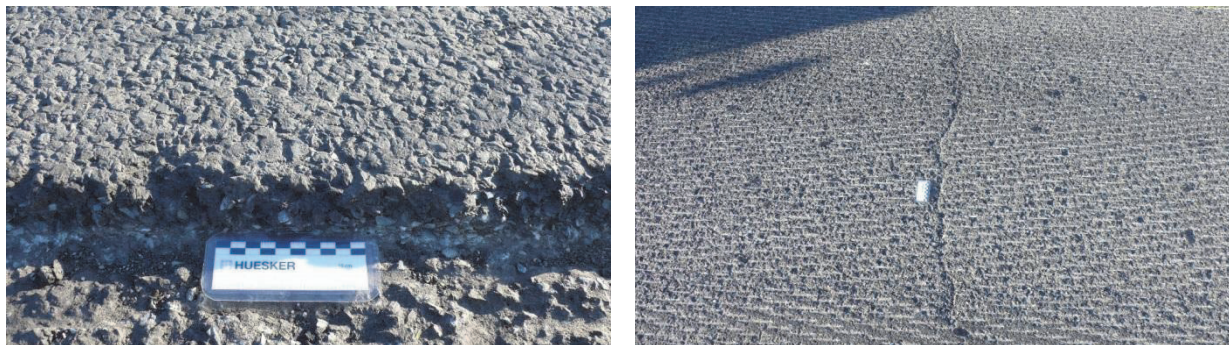
Figure 3. Support fraisé et fissuration des couches sous-jacentes.
