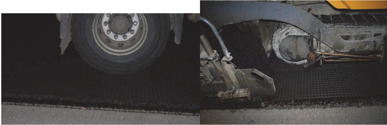
Figure 6. Collage parfait de la grille sur le support permettant le passage des semi-remorques et des finisseurs
