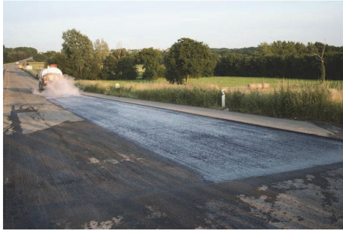
Figure 4. Épandage de l'émulsion bitumineuse sur le support fraisé
