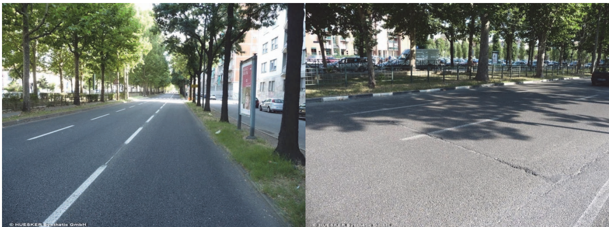
Figure 11. Comparaison du Corso Giovanni Agnelli à Turin (Italie) 4 ans après la réhabilitation entre la section renforcée (à gauche) et la section non renforcée (à droite)
