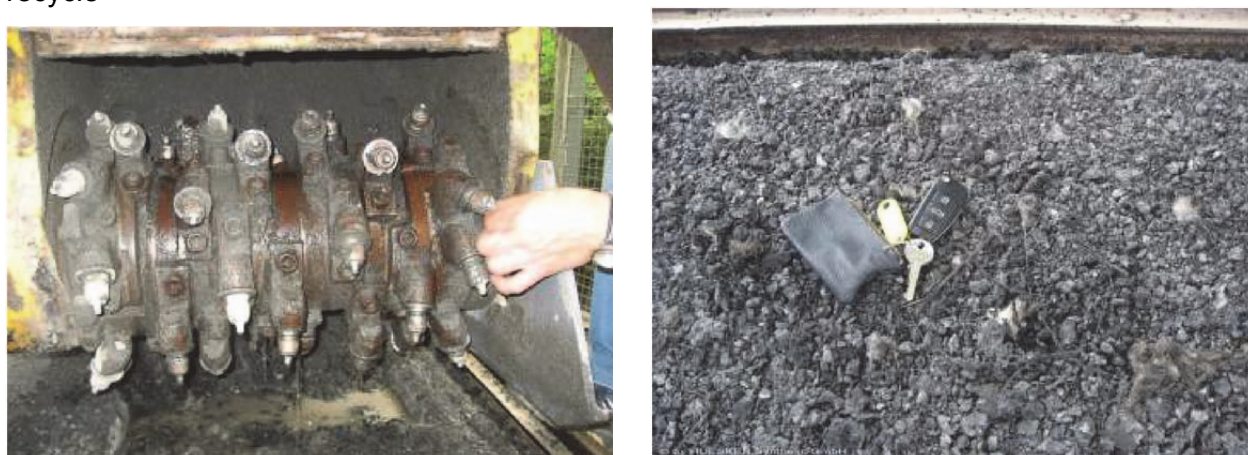
Figure 12. Fraisage aisé d'un enrobé renforcé par la grille polyester
