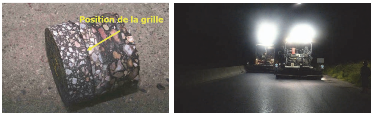
Figure 5. Exemple de liaison optimale entre la grille antifissures et les couches d'enrobé (à gauche). Enrobé mis en œuvre en nocturne (à droite)
